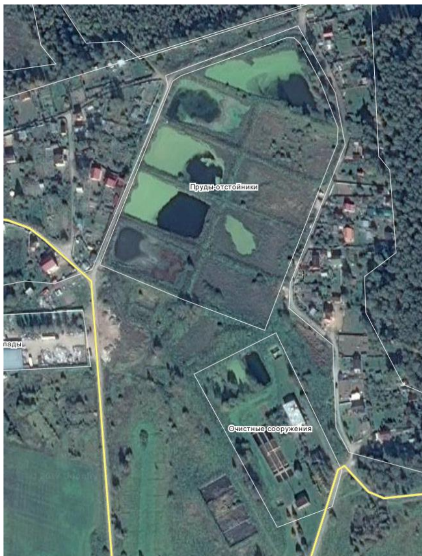
Рисунок 7 – Расположение очистных сооружений АО «Краснополянская птицефабрика»
